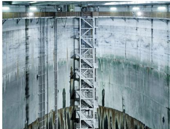
En las afueras de Tokio, la capital de Japón, se ha construido un canal de drenaje subterráneo de primera clase mundial. El túnel excavado a unos 50 m bajo tierra se extiende 6,3 km en total.
